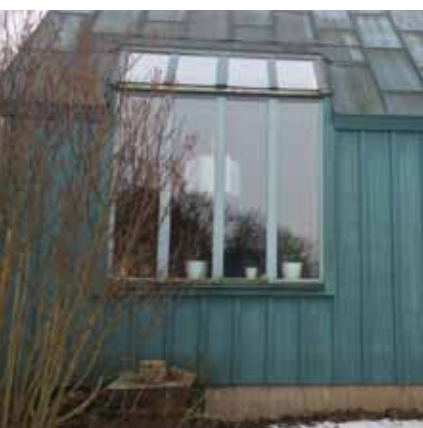
Ateljéfönster i norra delen
