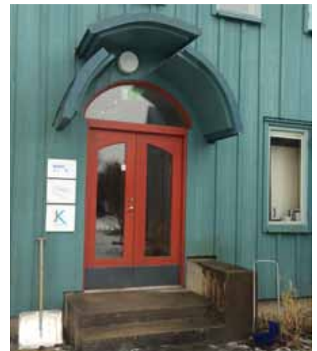
Entré med detaljer, tak och fönster
