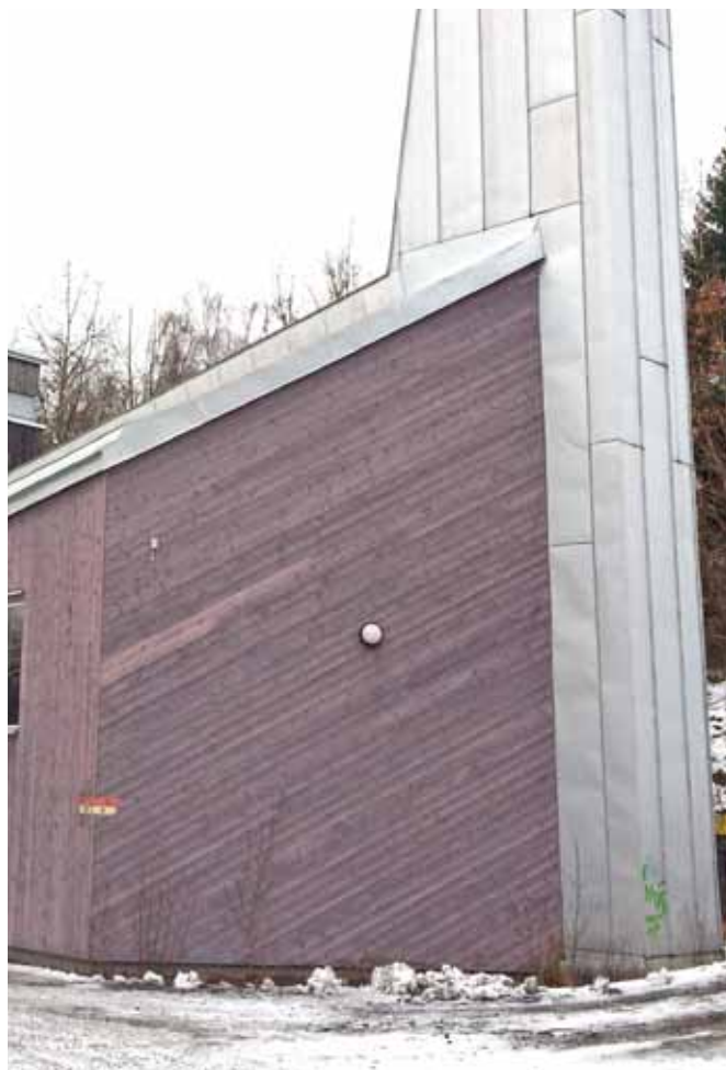
Detalj av fasad närmast skorstenen
