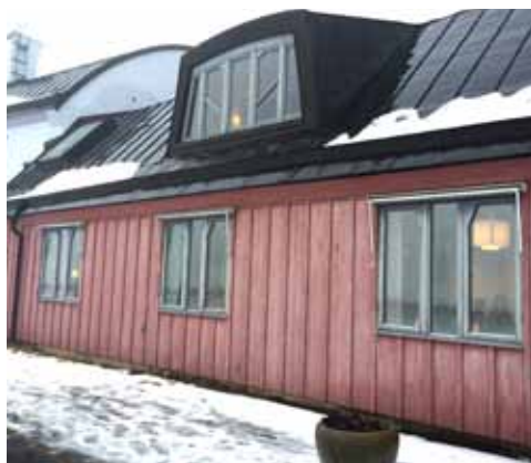
Fönsterdetaljer på västra sidan
