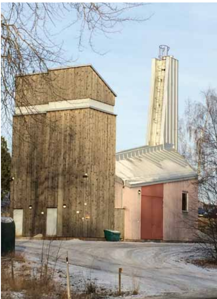
Vy från vägen mot panncentralen
