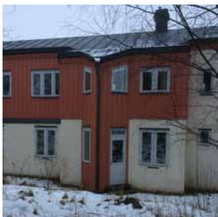
Detaljering, träpanel i burspråk
