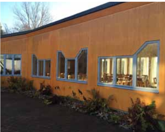
Matsalsfönster mot atrium
